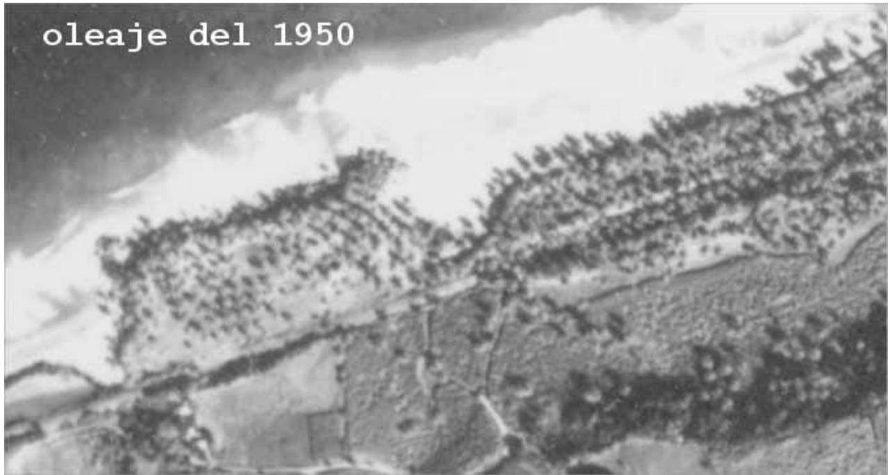
Figura 2. Foto mostrando penetración del oleaje.
